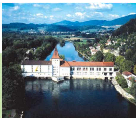
La centrale hydroélectrique IBAarau à Aarau vue de face
